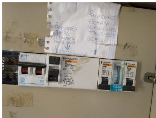
Imagen 18. Reloj horario situado en el CGBT
